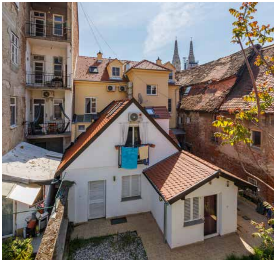
Zapadno začelje Dvorišna kuća
